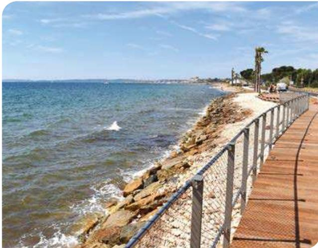
**Le projet consiste à mettre en œuvre une protection par butée de pied en enrochements, associée à un rechargement type gravillons/galets.** L'ouvrage permettra de retrouver une plage plus large avec de petits galets, ce qui améliorera fortement l'aspect paysager du site. Cette solution ne générera aucune gêne pour les activités nautiques et permettra un bon renouvellement et une meilleure qualité des eaux de baignades.
