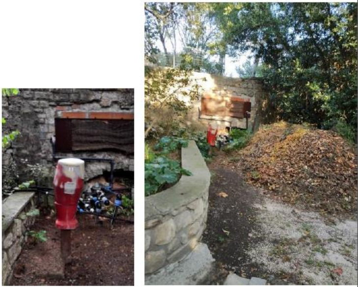
Borne incendie existante - Source : terrain ALTEREO
