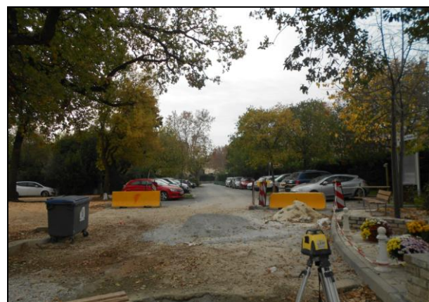
Parking faisant face au site, au sud de la rue Paulin David.
