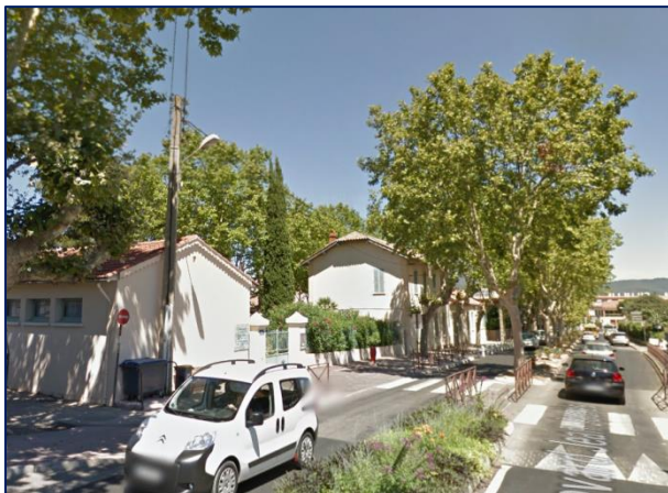
Vue du front bâti de l'ancienne école depuis le boulevard Jean Jaurès
