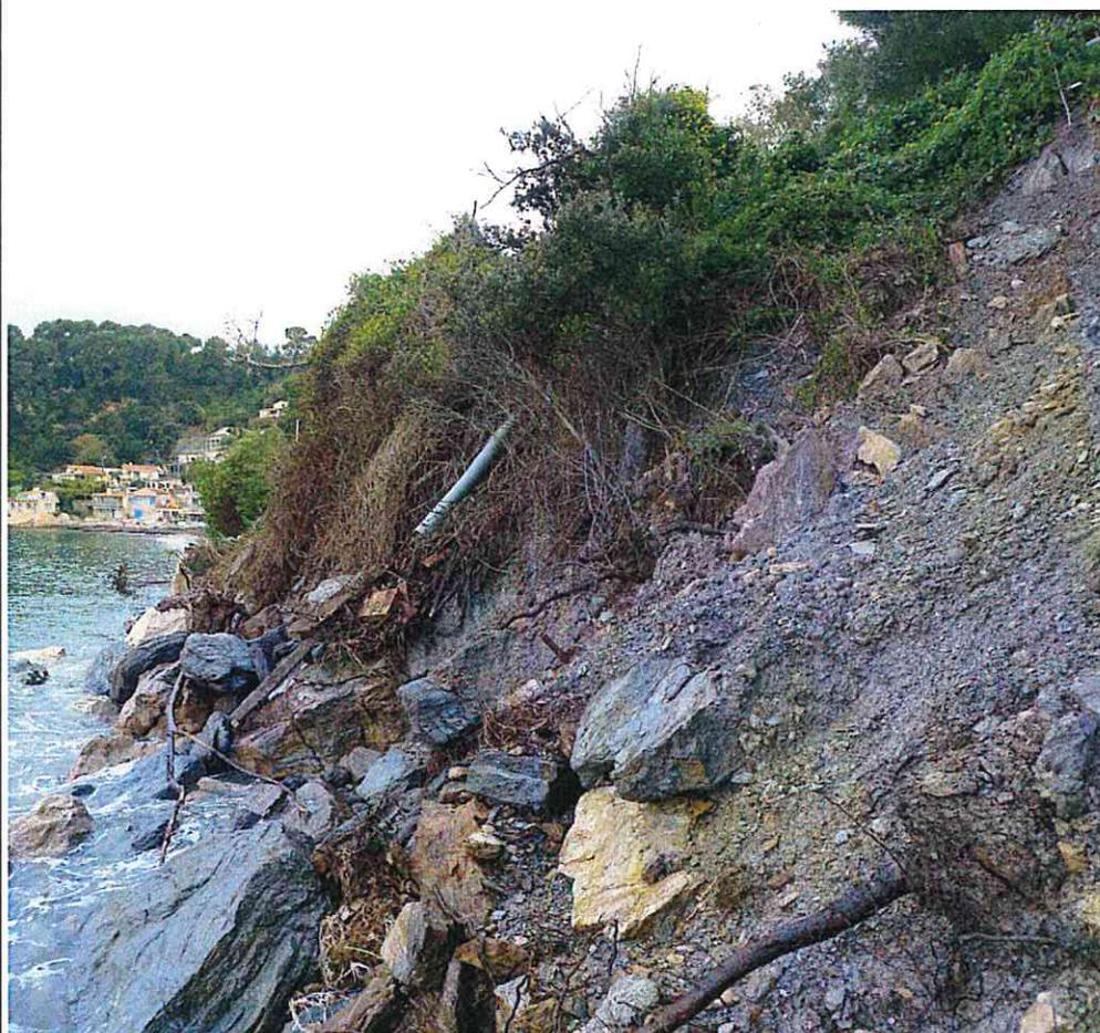
Important affouillement par la mer au-delà de l'extrémité d'enrochement (ici ré enseveli par le glissement)
